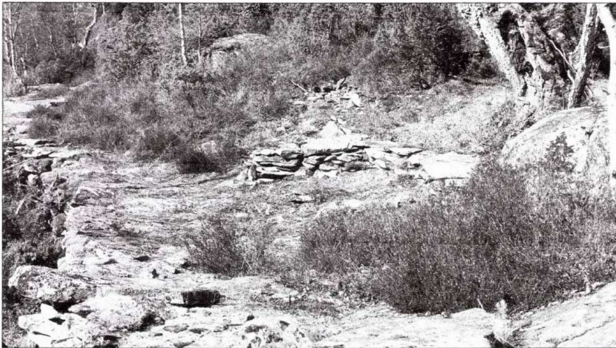
Noko av Tennevegen går over svaberg. Her er det lagt opp murar og murføter, og til dekke på vegen er det brukt svære steinheller. Hellene er truleg tekne ut i nærleiken. På biletet ser me og Ja-benken, som nok vart meir nytta før.
