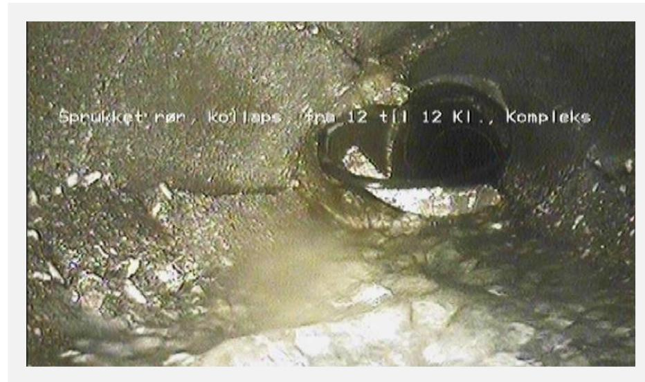
Figur 6 Kollapsa røyr ved Tenål før saneringa. Foto: Norva 24
