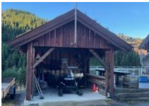
Bilete 7.1-13 Grindbygg. Foto: Norconsult
