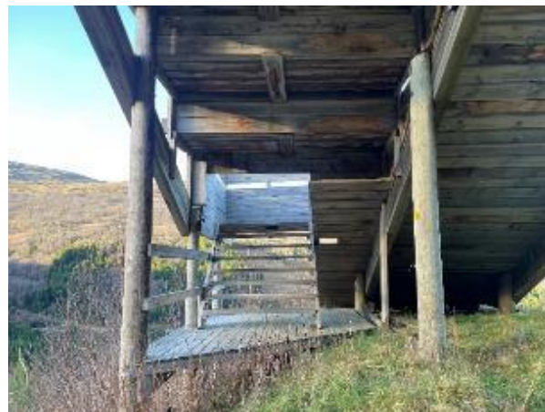
Bilete 5.7-7 Status underside og trapp. Foto: Norconsult
