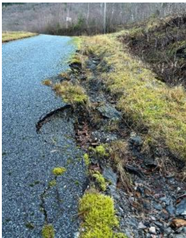
Bilete 5.3-4 Skade på rullerulleskiløype. Foto: Norconsult
